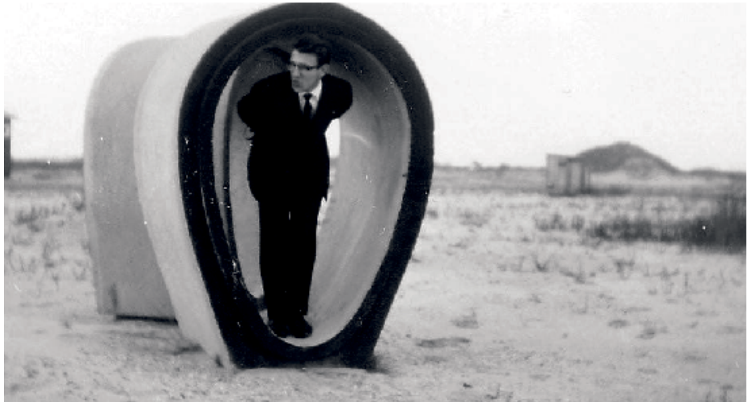
Foto: Piet in een rioolbuis, die in de grond gelegen is ten behoeve van het rioleringsysteem in het dorp Dronten.
