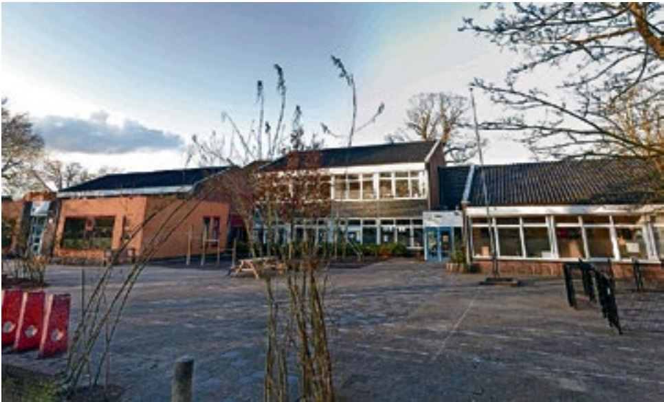
De Turfmarkt voor de sloop van de gebouwen. Na het verdwijnen van het Stilo zwembad – nu appartementencomplex De Filosoof – en de verbouwing van de watertoren tot appartementen krijgt deze plek opnieuw een ander aanzicht.
