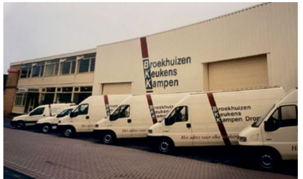
Bedrijfsspan aan de Ambachtsstraat in Kampen
