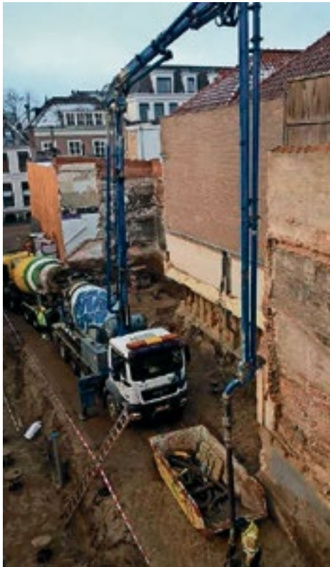
Het pand van X-Ray werd vanaf 2018 gesloopt om plaats te maken voor appartementen. Foto: Facebook Bouwbedrijf Ufkes.
