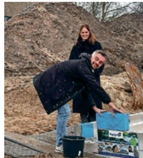
De start van de bouw aan de Randweg.
