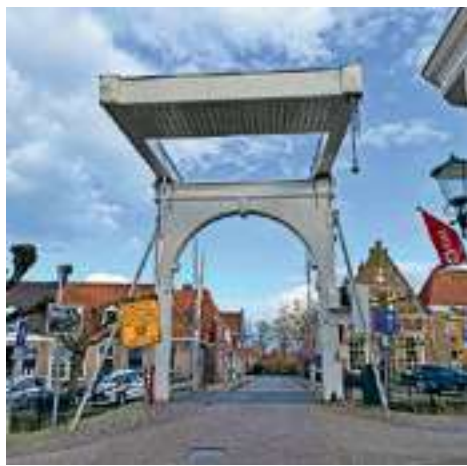
De Verlaatsbrug vlak voor de werkzaamheden begonnen. Foto: Anja Bos.
