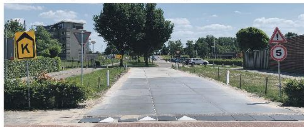
Door betonplaten aan te leggen op het grasveld tussen Taghof en de Prikker is een tijdelijke weg gecreeerd die de bereikbaarheid van de wijk Achter 't Tag verbetert. Foto: Anja Bos
