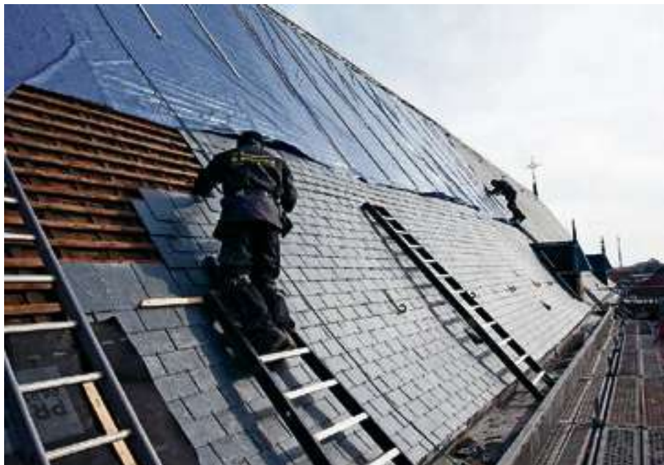
Het dak van de Sint Clemenskerk wordt voorzien van nieuwe leien. Foto: Sieb van der Laan.
