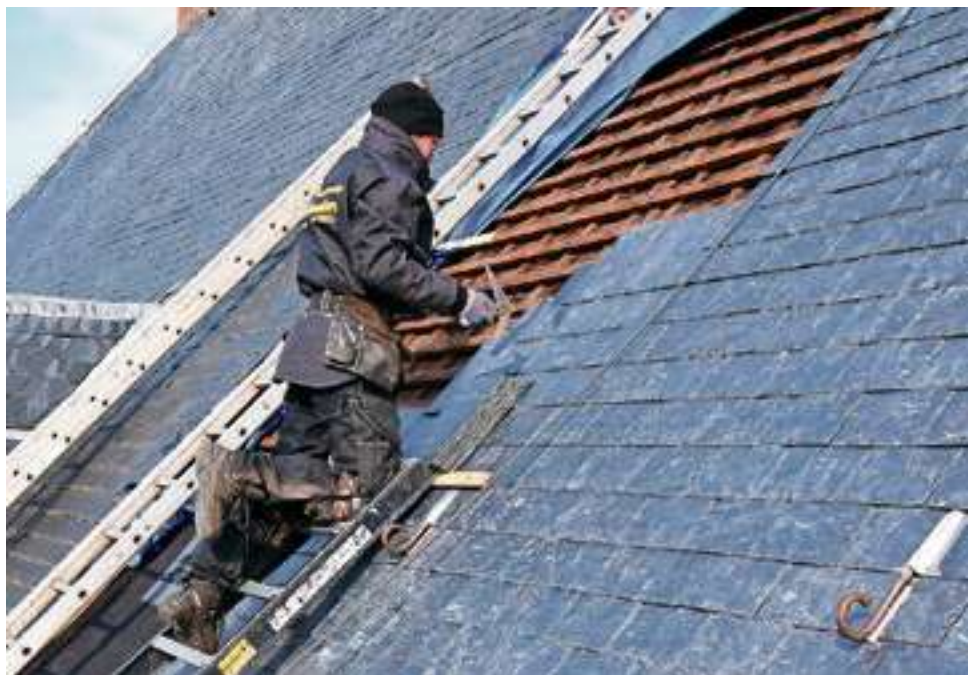
Het dak van de Sint Clemenskerk wordt voorzien van nieuwe leien. Foto: Sieb van der Laan.
