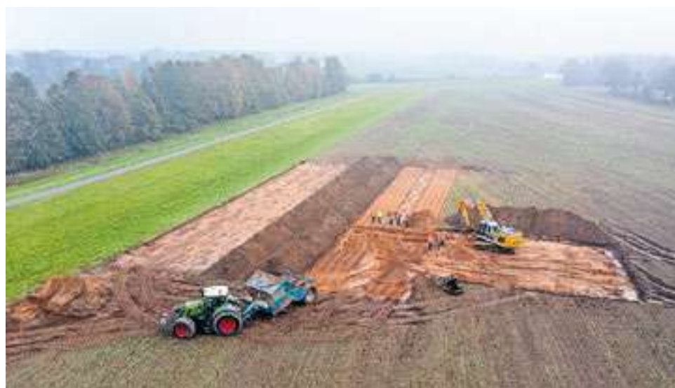
Het waterschap meet of het mengen van de zandgrond met de kleilaagjes voldoende is om het effect van piping langs de Vecht te voorkomen. Foto Demi de Kleine
