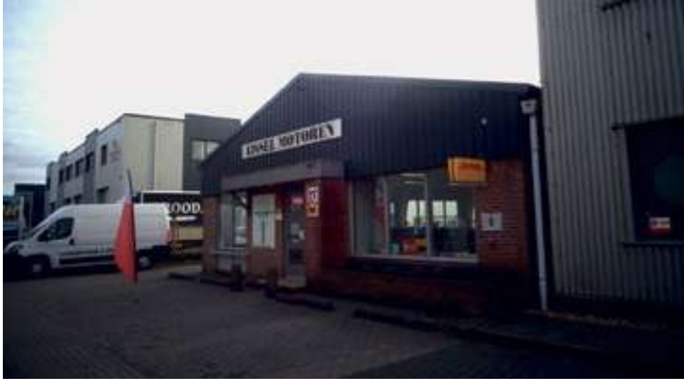
Het ruime pand van Ijsselmotoren, op loopafstand van station Kampen.
