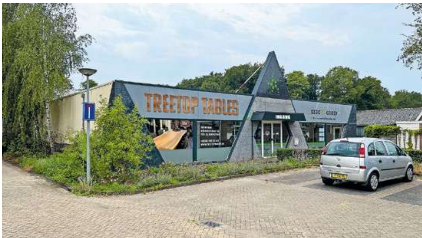
foto van het nieuwe pand aan de Zwolseweg 18 te Balkbrug.
