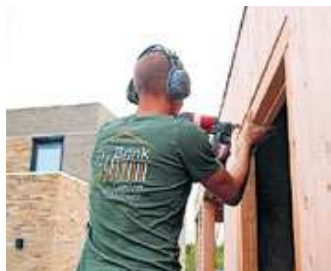
Ondergrond en het tuinhuisje: alles van a tot z wordt in de tuin gemonteerd. Eigen foto's
